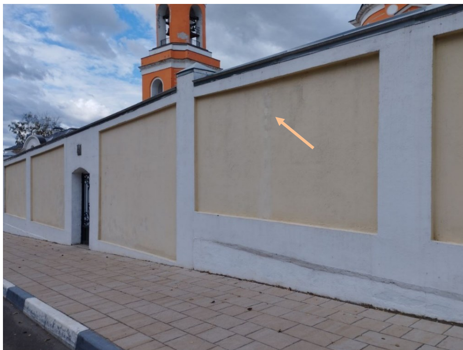
Рисунок 1. Южная часть Никитского монастыря, 3-я секция от главного входа (внешняя сторона)
