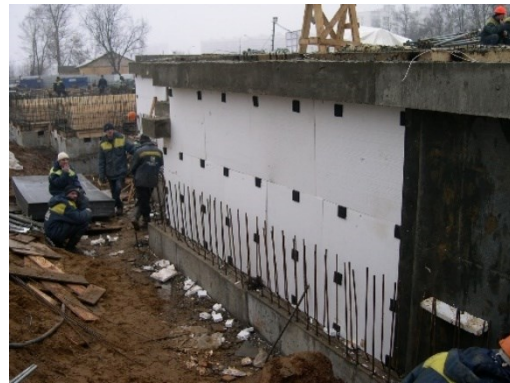
Рис. 20. Монтаж резиновых виброизоляторов на боковой стене здания в процессе строительства
