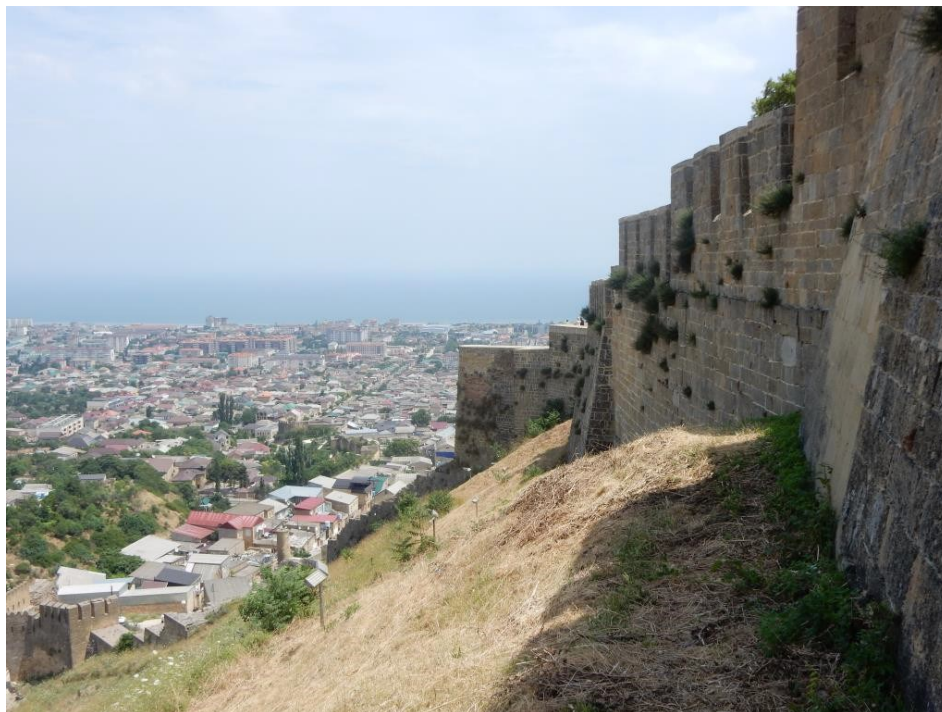
Рис. 4. Проявление биологического выветривания в северной стене цитадели Нарын-Кала
