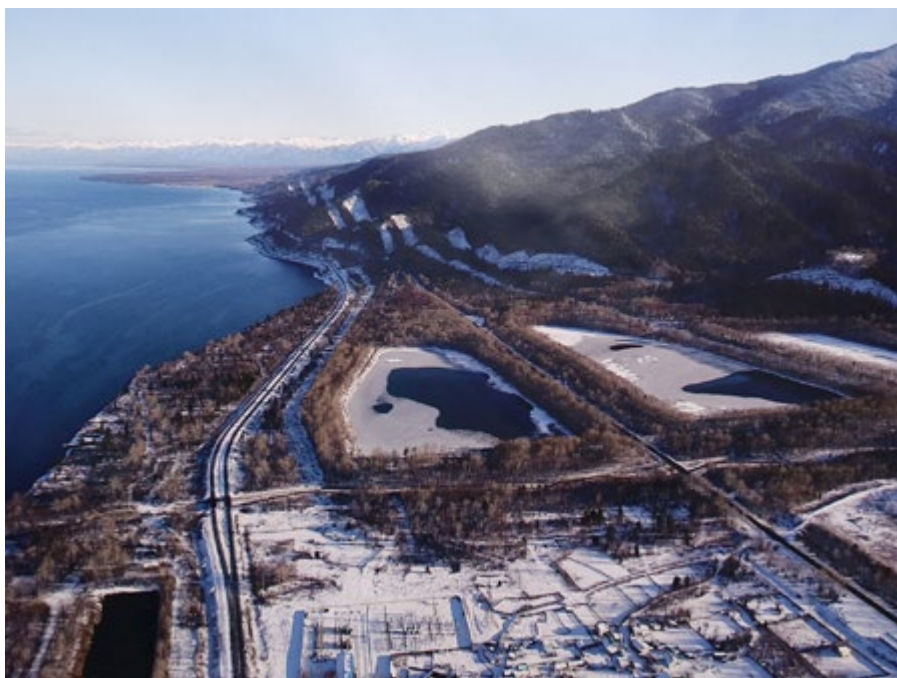
Солзанский полигон промышленных отходов
