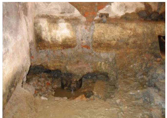
Рис. 4. Лежень и деревянная свая из фундамента дома по адресу: Набережная Фонтанки, 7
