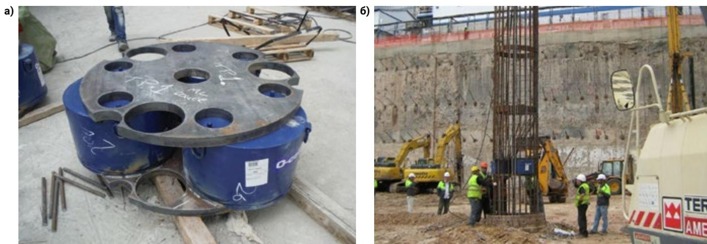
Рис. 1. Общий вид погружных домкратов (а) и погружение каркаса, оборудованного погружными домкратами в скважину (б)
